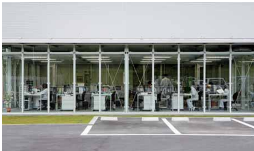
駐車場より事務棟を望む。
