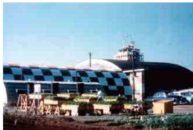
ハイドロポニックスファームに設置された温室。煙突は暖房用ボイラーのもの。画像提供:日本養液栽培研究会(JHS)
