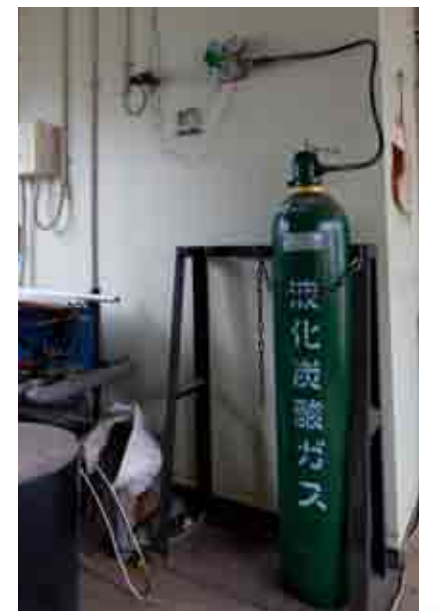
室内に二酸化炭素を送り込み、光合成を促すことで栽培スピードを高めている。
