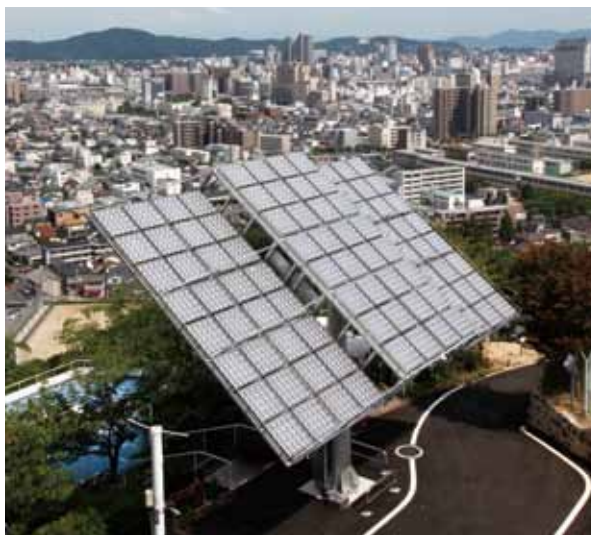
自動で太陽光を追尾する集光型太陽光システム。岡山市内の景色が一望できる。
