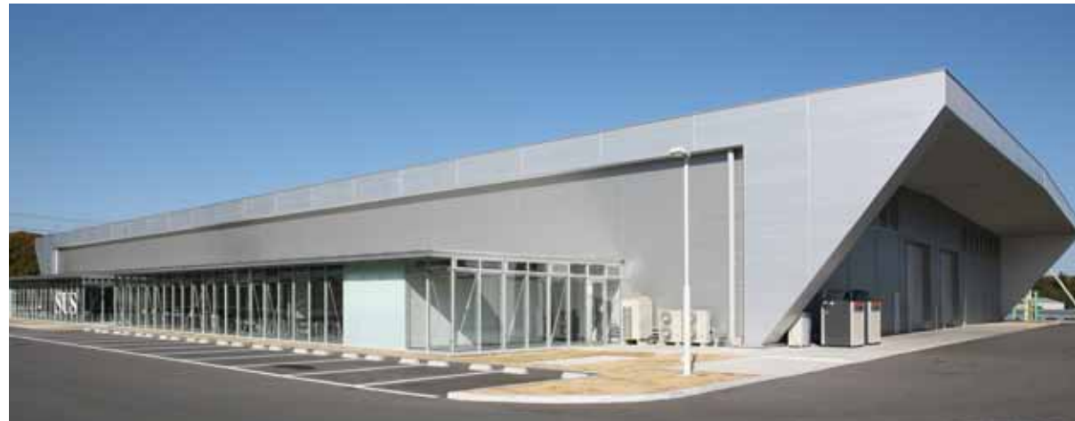
滋賀事業所外観。手前の事務所スペースは、SUSの技術力を生かしたアルミ建築で構築されており、建物にもSUSらしさが表れている。
