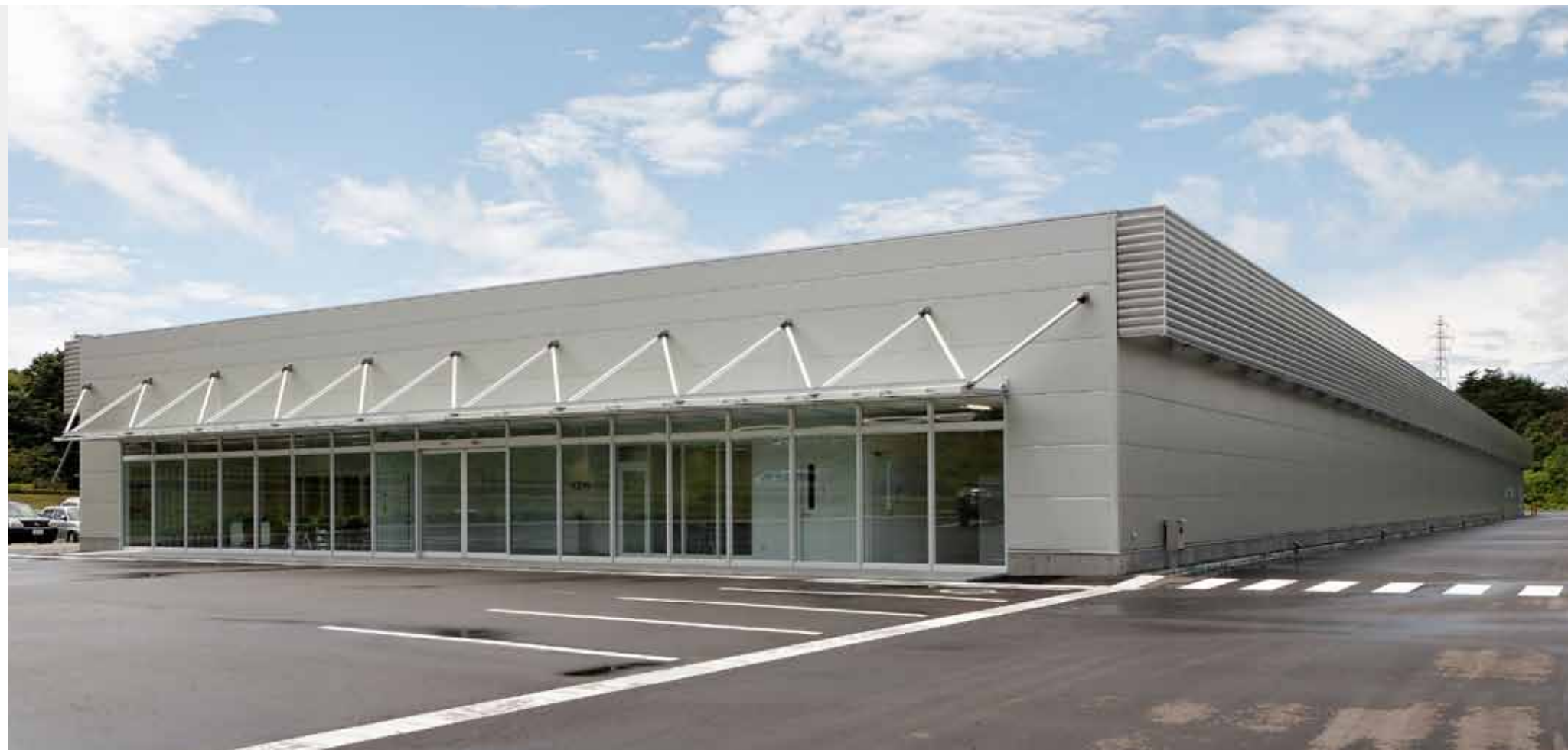
震災の影響で工事が一時中断し、2カ月遅れで6月に竣工した組立工場。長手方向の外壁側面には、雨水の処理と排気口の目隠しを兼ねた全長114mに渡る固定式のアルミルーバーが取り付けられている。正面の庇(ひさし)取り付けには、新開発のトラスシステムが用いられた。
