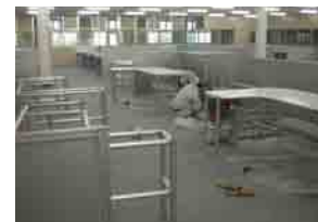
④ 天板を組み付けて完成!工程ごとに分担して作業にあたった。
