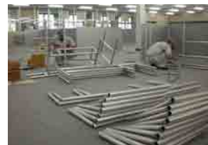
③ 脚部が組み上がった時点で上下を逆転。
