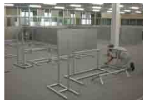
② 1台分のパーツを並べ、順番に組み付ける。
