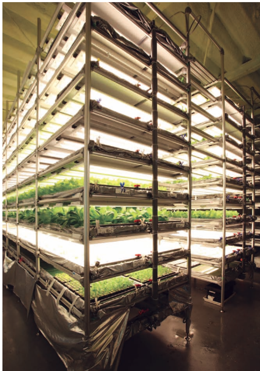
栽培棚は1ユニットで10(m)×1.3(m)×3.8(m)。蛍光灯の必要ない播種用の棚も合わせ、最大で10段の3ユニットからなり、組立はSUSが担当した。
