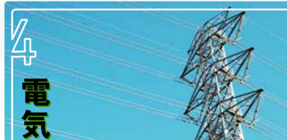
アルミニウムは導電体として極めて経済的な金属です。電気伝導率は銅の約60%ですが、比重が約1/3であり、そのため同じ重さの銅と比べて2倍もの電流を通すことができます。現在では高電圧の送電線に使用されるとともに、導体(板・管)などに広く使われており、エネルギー利用、エレクトロニクス分野での需要が大きく伸びています。最近では自動車のワイヤーハーネスにも使用され始めています。
