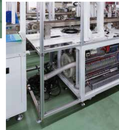
改修によって延長されたコンベアを支えるため、新たにSFを継ぎ足して対応。拡張性の高さが非常に役に立つとのこと。
