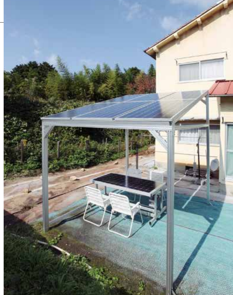
屋外に設置されたソーラーエクステリア。実際に発電をしながら検証を進めていく計画。
