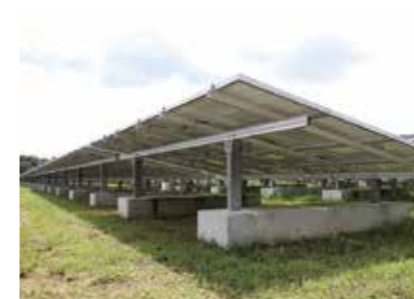
太陽光パネルを陰で支えるアルミ架台。
