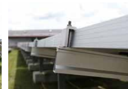
アルミ押出材のT溝を用いたボルト締結は施工も簡単。
