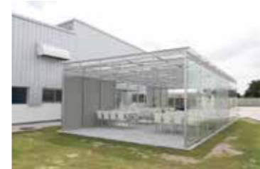
食堂や休憩用のスペースは工場棟の隣に用意。SUSのアルミ押出材で構成されている。
