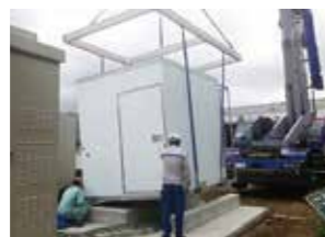
工場を組み立てたアルミ製PCSシェルターを現地へ運び込み、設置する。
