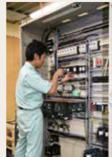
本社工場における制御盤製作の様子。
