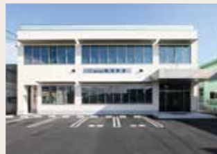
静岡県静岡市に立地する本社は工場併設。2012年に新社屋が建てられた。
