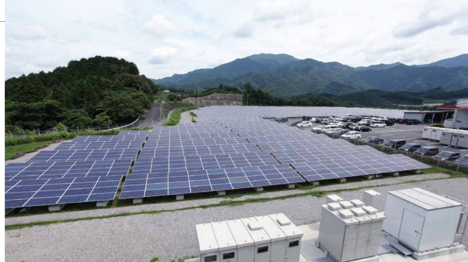
4,836枚もの太陽光発電パネルと関連製品群を工場屋根より望む。手前右端がSUSのアルミ製PCSシェルター、他は日東工業社製品。
