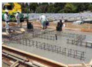
基礎工事の様子。
