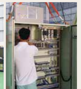
制御盤の組立を行うタイの従業員。
