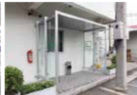
ecommsの喫煙ブース
