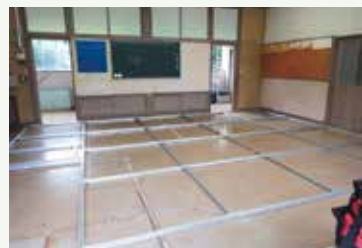
かつて職員室だった教室に栽培室のベースとなるアルミフレームを組み上げる。
