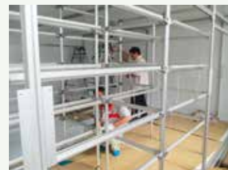
GF製の栽培棚は全部で3台。栽培室の組立と並行し、組み上げていく。
