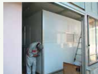
最後のパネルを組みつけ、栽培室が完成。見学を想定し壁面に窓を設けた。
