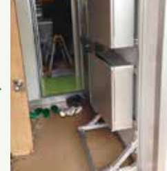
完成した栽培室に設備を動かすための制御盤を設置するなど、電気工事を施していく。
