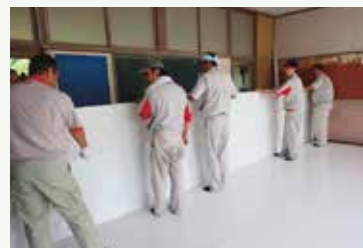
軽量のアルミパネルは人力での運搬・組立が可能。室内での施工もラクラク。
