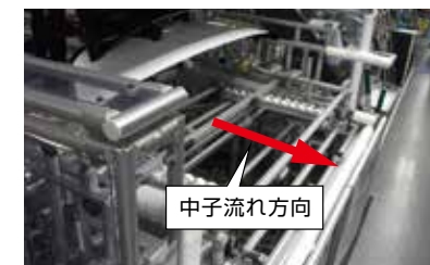
リフター上昇後に搬入される中子
