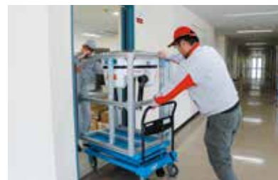
今回、一番狭かったのは、設置する部屋の扉の間口。組立前なら台車での搬入が可能。
