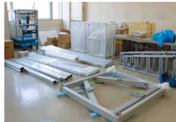
運び込まれた部材とロボット。天井部分と付帯設備の一部はあらかじめ工場で組み立ててから持ち込んでいる。
