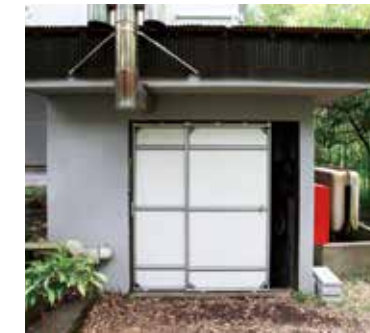
上部は引戸のレールをそのまま使い、グリーンフレームS SSスロットで滑らせている。
