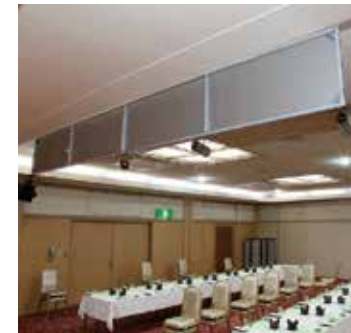
GF-Sフレームで骨組みをつくり、パネルを貼り付けている。
