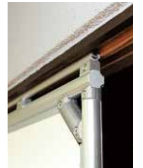
上部は引戸のレールをそのまま使い、グリーンフレームS SSスロットで滑らせている。
