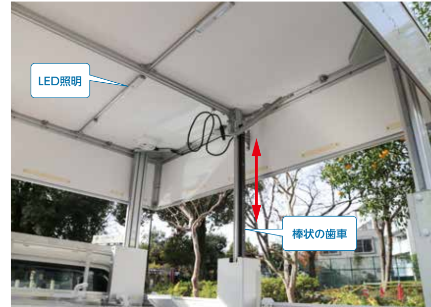
荷箱内部から見た、天井および昇降の機構。SUSではこの機構と骨組み、パネル材などの製作を担当した。
