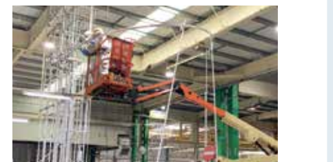
設置工事の様子。空中搬送路の取り付けは、設備部と協力して実施した。
