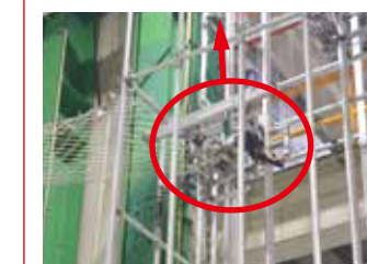
昇降台にセットされた治具がモーターの力で昇降装置内を上昇。
