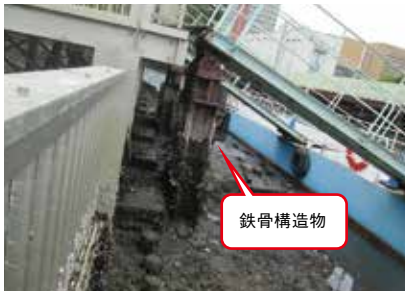
柱脚X8列と鉄骨構造物
