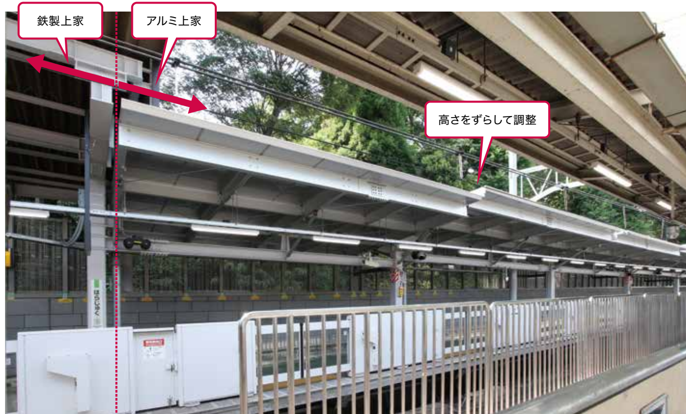
内回り線ホームから見たアルミ上家。ホームの傾斜に合わせるため、柱部分で屋根の高さをずらして調整している。
