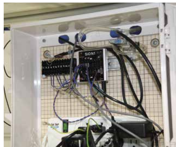
e-CONではつながらないため、最初はSiOとカメラの配線に苦労したとのこと。端子台を使うなど徐々に制御盤内の完成度も高めている。
