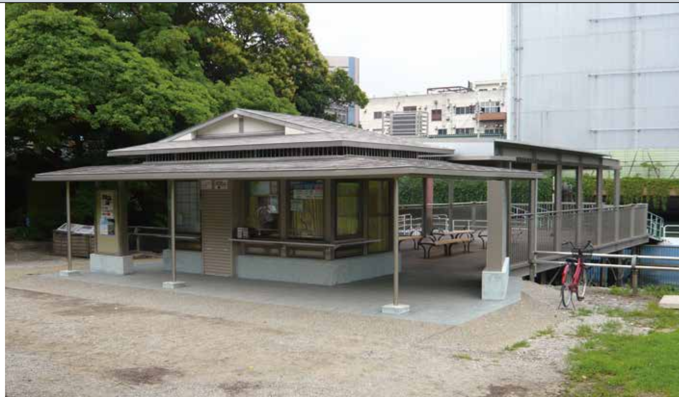
浜離宮恩賜庭園船着場の券売所とアルミ栈橋。以前の栈橋には鉄骨が使われており、腐食がひどかったことから、耐食性に優れたアルミの採用に至ったとのこと。
