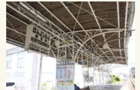
キノコ状に組まれた9本の柱と、間をつなぐ桁梁は、それぞれ複数の三角形からなるトラス構造で形づくられている。
