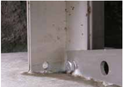
柱脚X1Y1の下部の様子
