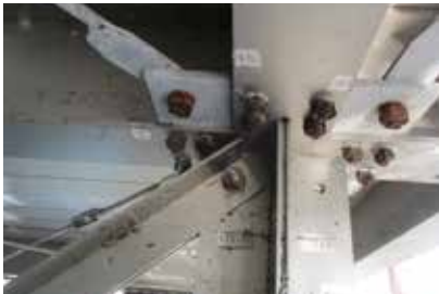
床下梁部の接合部の状況
