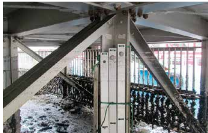
暴露試験のため、柱脚に固定された試験体。
