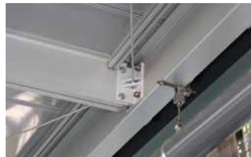
屋根部分の梁材の接合とブレースの固定には専用のアルミダイカストパーツを使用。
