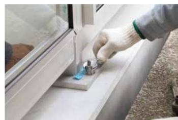
コンクリート基礎と待合所の躯体をナットで固定。
