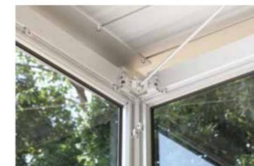
ZFフレームの溝を使い、プレースを留めるアクセサリを取り付けています。
