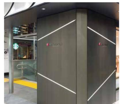
押出材による壁装飾。幅の異なる押出材を並べることで、独特の模様を生み出している。
