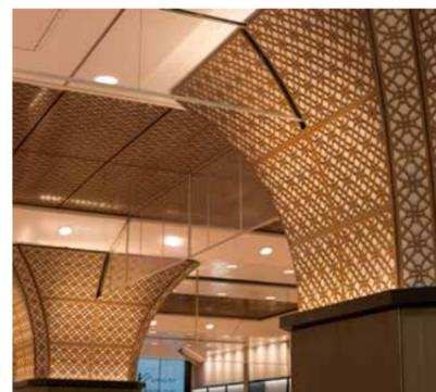
天井と柱の上部を飾る桜モチーフのレリーフ。圧延でつくられた板をレーザーカットで加工している。
