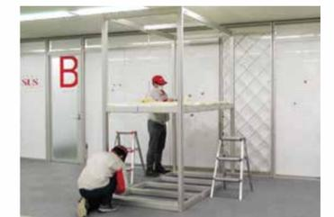
さらに柱を立てて、上の面をはめ、ジョイント部分のボルトを締め付けて、骨組みが完成。
