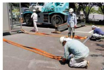
設置場所の近くで、吊り上げ用の治具を取り付ける。
