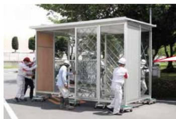
組み上がった待合所の躯体を平台車に乗せ、人力で現場へ運搬。
