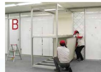
壁を固定するためのパーツをフレームに取り付け、順番に壁を組み込んでいく。
