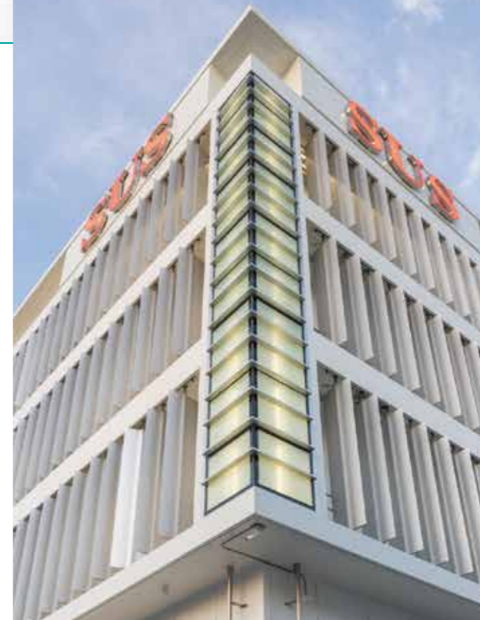
地上から見上げた本社工場。羽板の可動範囲は最大120°で、取り付けられている方角に応じて異なる数値で設定されている。
