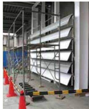
2007年、タイでの工事を前に日本で製作されたモックアップ。
