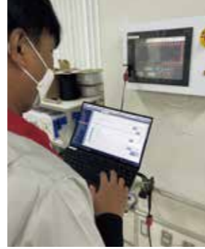
制御用のプログラムをフロアに設置されたタッチパネルへ書き込む。
