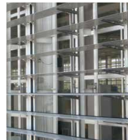
1分間に1350回転するモーターのギア比を1/1440に抑えて1分間に約1回転まで減速させ、ルーバーの開閉に利用。0°から最大角度の120°まで20秒ほどかけてゆっくりと動く。
