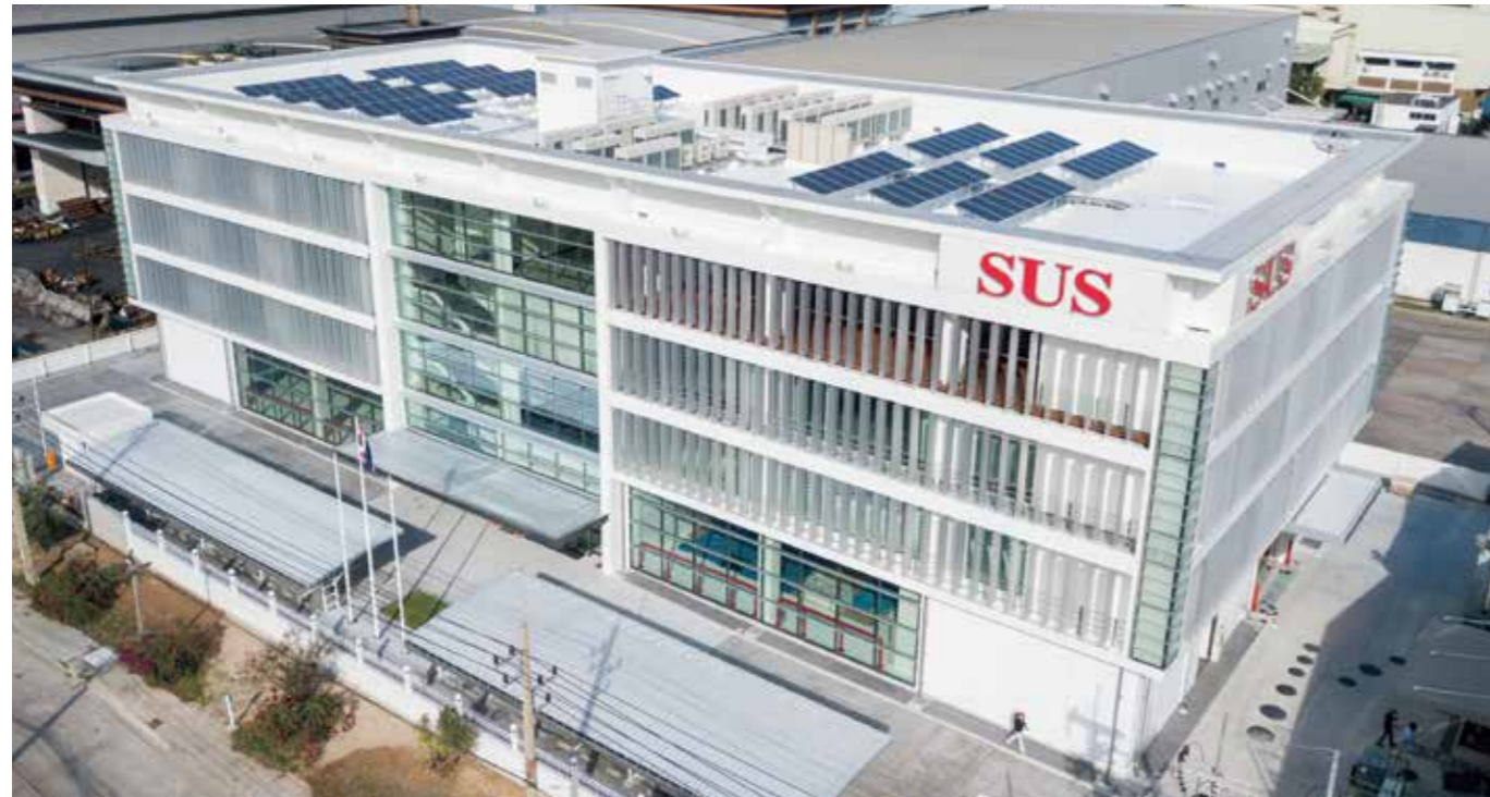
SUS BKKの新本社は4階建て。施工時は1ユニット分の電動ルーバーを固定する専用の治具をアルミフレームでつくり、クレーンで吊り上げて設置した。
