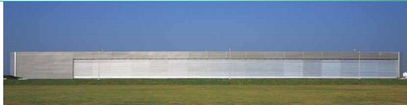
工場建屋は全長120m。電動ルーバーはその内の102mに取り付けられている。
