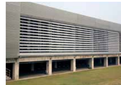
工場建屋は全長120m。電動ルーバーはその内の102mに取り付けられている。
