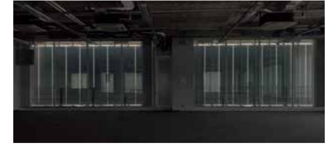
室内から見たルーバー開閉の様子
