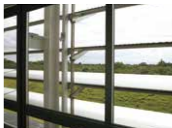
工場内から見たルーバー。室内との間には網戸が張られている。
