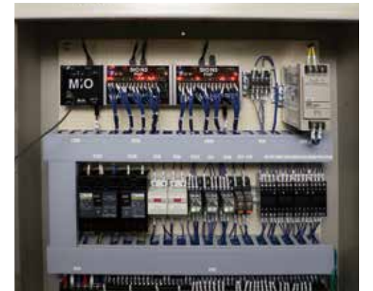
エアブロー用ロボットの初号機ではセンサやスイッチなど多数の機器との連動が必要となるため、MiOで入出力点数を確保している。
