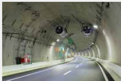
シールド工法でつくられた高速横浜環状北西線のトンネル。壁面にブロックの継ぎ目が見える。
