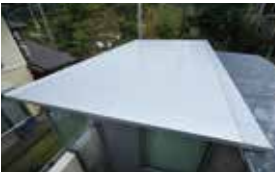
屋根は、ecomS独自設計のアルミ押出材を組み合わせて構成されています。
