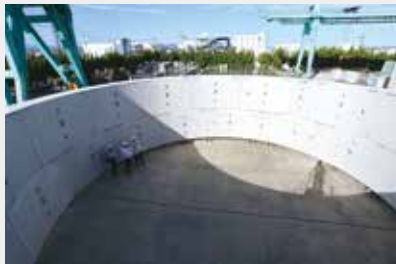
仮組みには足場がかけられ、内部に入ることが可能。
