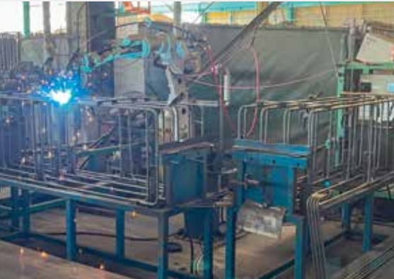
ロボットによる鉄筋カゴの自動溶接の様子。プログラムに従い、正確に作業が行われる。
