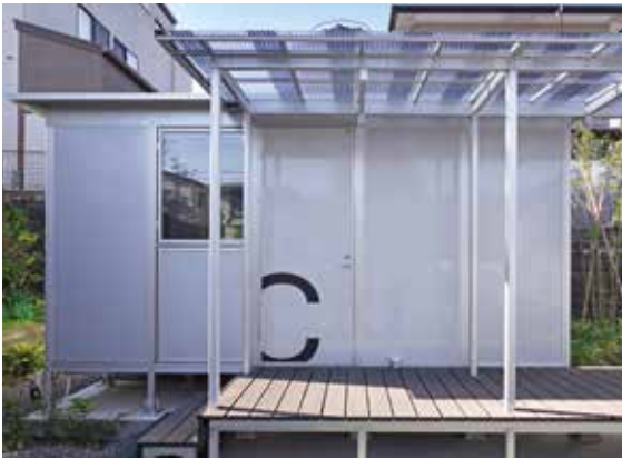
中庭から見たC棟。モデルハウスのt²-01は1つの設計例であり、窓の数や扉の位置などは自由度を持たせた提案ができます。
