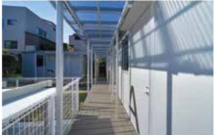
門扉を開けると数段のステップがあり、そのまま渡り廊下へ上がることができます。屋根付きで雨の日も安心です。
