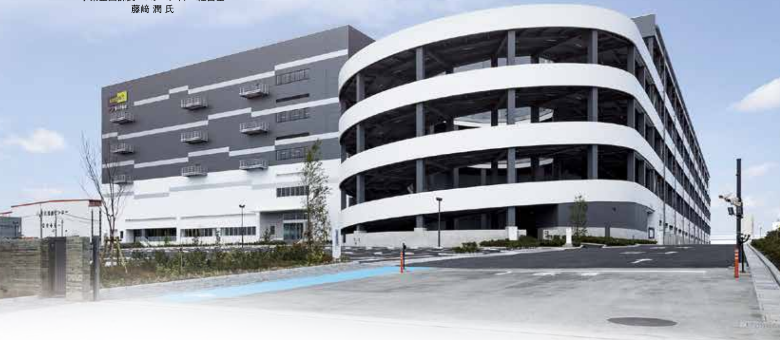
5階建て、延床面積43,000坪の大型物流施設であるLandport習志野の外観。
