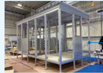
ジョイントに フレームを被せ、 皿ボルトで固定 高剛性アルミ構造材ZF
