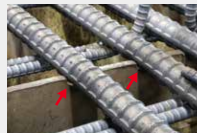
鉄筋の太さに合わせて加工された位置決め用の溝（赤矢印部）。高精度な専用治具により品質を確保する。
