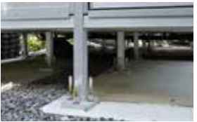
t²-01と工場で作られたプレキャストコンクリート(PCa)基礎の連結部分。
