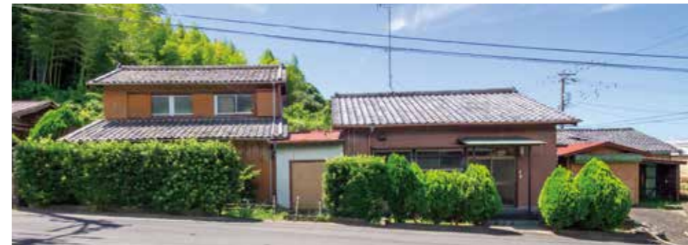
玄関は1階建ての建物の道路側に設けられており、写真向かって右側には車を入れるガレージなどが建っています。
