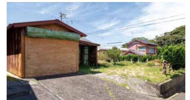
ガレージは取り壊し、3台駐車可能なカーポートを設置する予定です。
