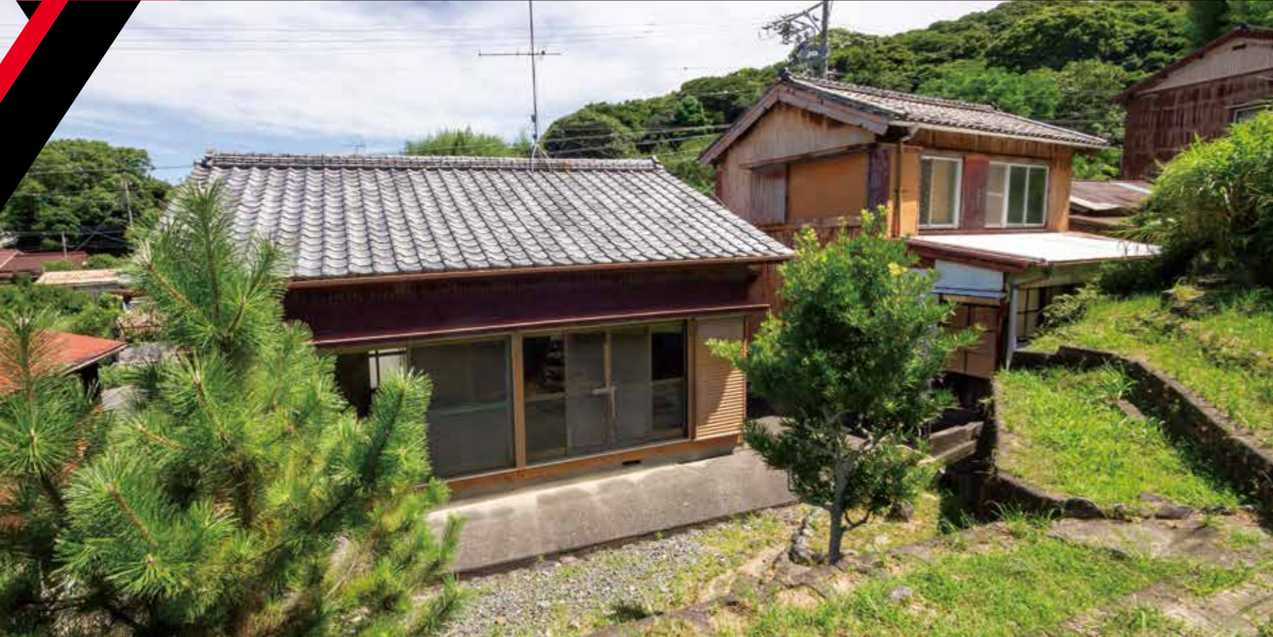
敷地内から撮影した、改修工事前の空き家。1階建てと2階建て、2棟の建物を連結した構造になっています。
