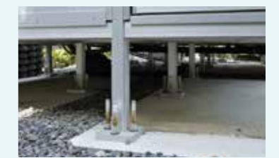
以前はZF製の長い柱脚による高床式構造を採用。柱脚と本体は別に組立を行い、現地で連結する設計でした。
