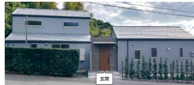
改修工事に伴い、玄関の位置は2棟の建物をつなぐ渡り廊下部分に移されました。
