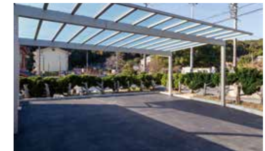
自動車3台の駐車可能なカーポートを設置しました。
