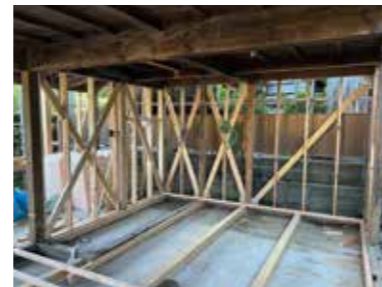
補強用に追加された色味の薄い新しい木材と、色の濃い既存の古い骨組みが混在しています。
