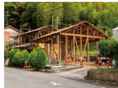
解体作業中の建物。壁や建物内の設備を全て取り外し、建物の骨組みのみを残します。
