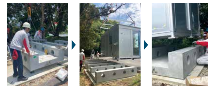
トレーラーで運搬したPCa基礎と本体をクレーンでつり上げて順番に下ろし、アンカーボルトで連結します。
